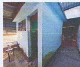
foto 6: pintura en muros
