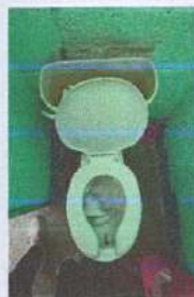
Foto2: Sustitucion de baño y lavamanos que se quebró
