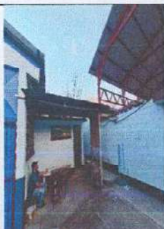
Foto 3: Sustitucion de cubierta de lamina y estructura sustitucion de puerta
