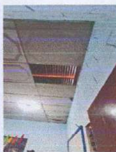
Foto 4: Sustitucion de 9 planchas de cielo falso por quebraduras
