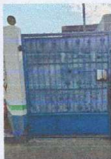
Foto 5: Sustitucion de porton de acceso por oxido y deteriorado
