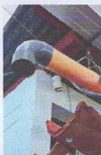
foto 5: Sustitucion de canal y bajadas de agua pluvial
